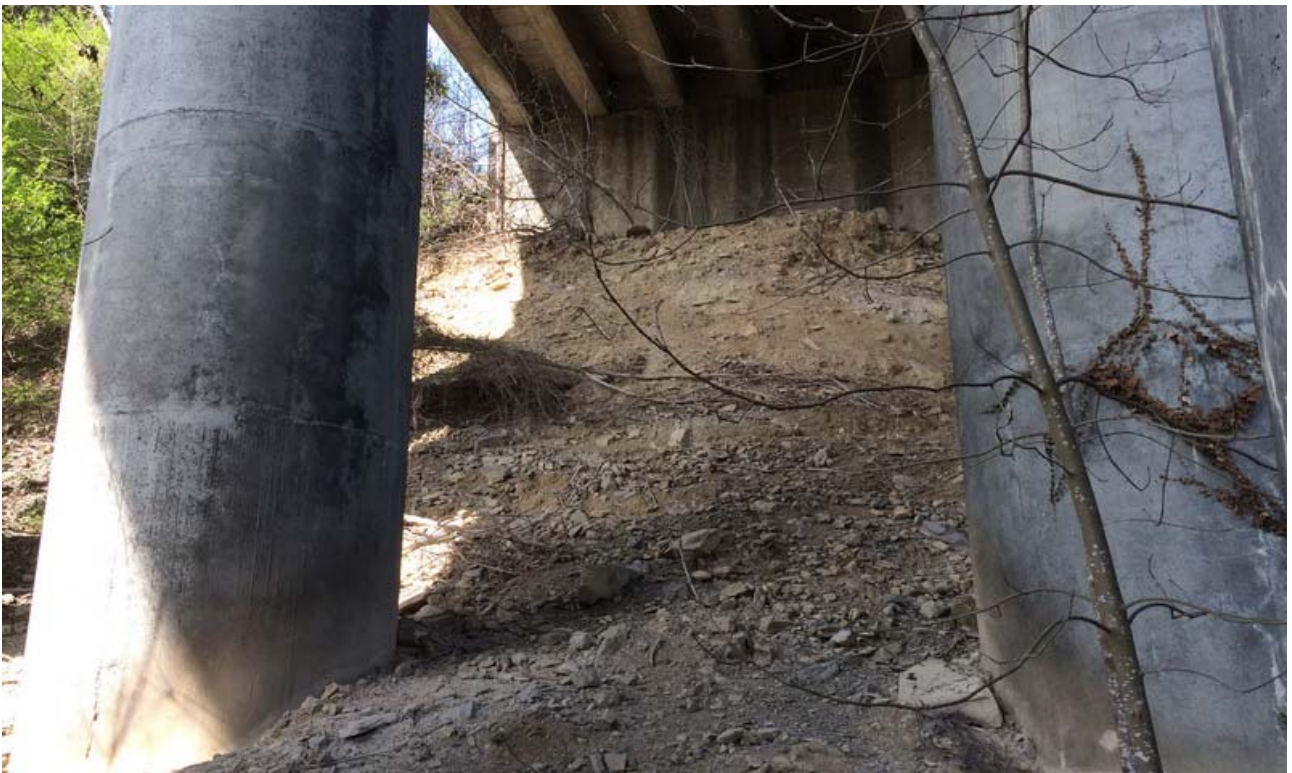
Figura 27: Vista 13, spalla lato Bologna
