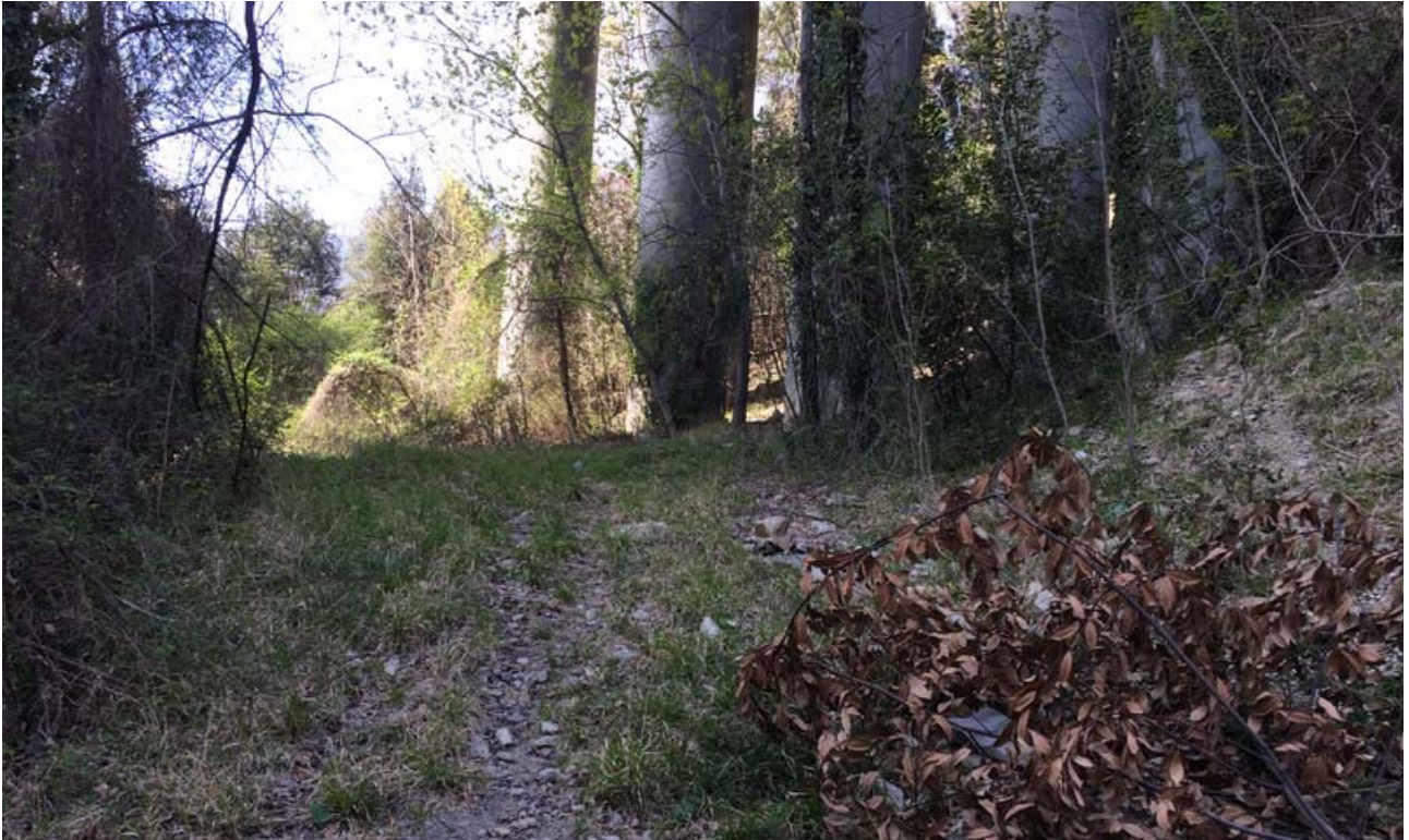
Figura 26: Vista 12, spalla lato Firenze
