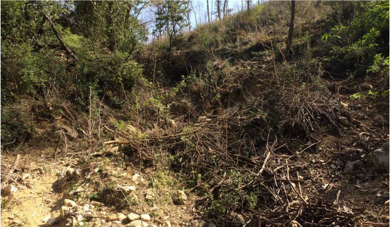
Figura 22: Vista 8, fossato in rilevato
