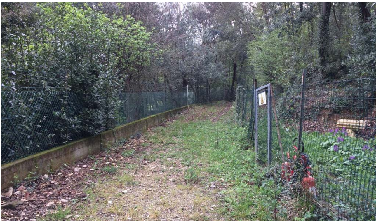
Figura 17: Vista 3, pista di cantiere da sistemare (pista tipo 1)
