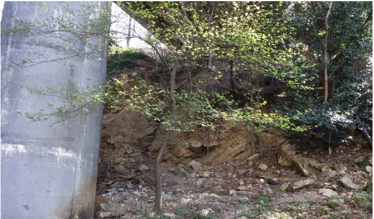
Figura 24: Vista 10, spalla lato Firenze
