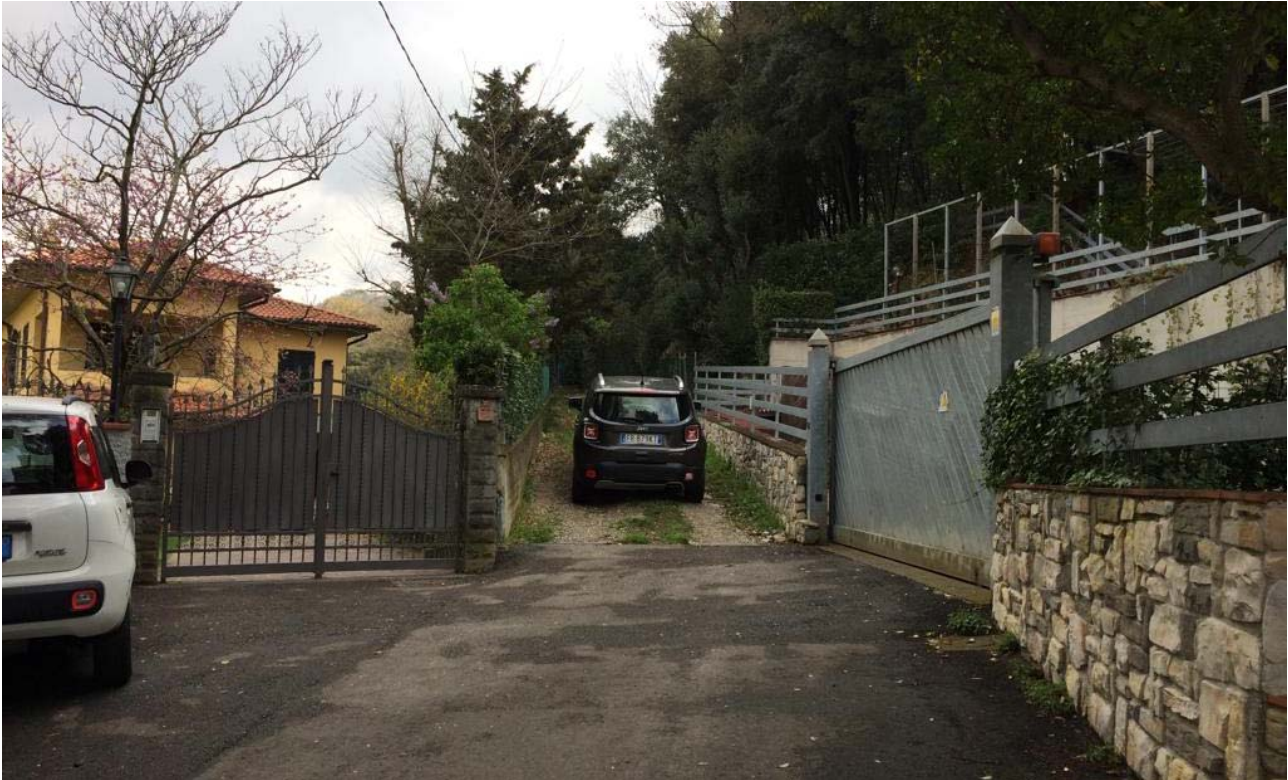
Figura 16: Vista 2, inizio tratto di strada non asfaltato da sistemare (pista tipo 1)
